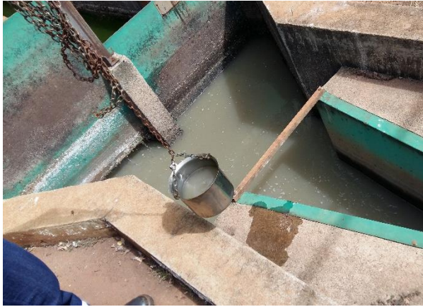
Figura 7. Coleta dos efluentes na entrada da ETE IV. Data: 04/05/2017.
